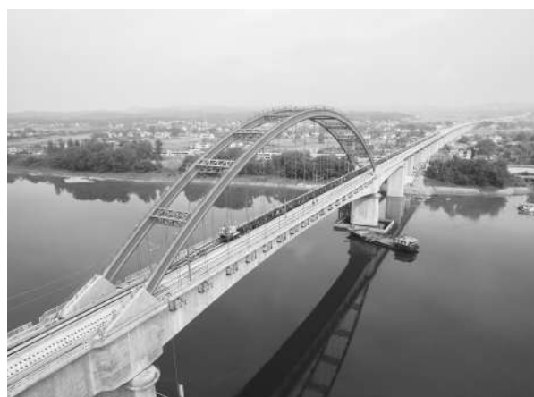
7月18日，轨道铺设顺利通过常(德)益(阳)长(沙)铁路控制性工程资水特大桥。据了解，常益长铁路线路全长约157公里，设计时速350公里。
