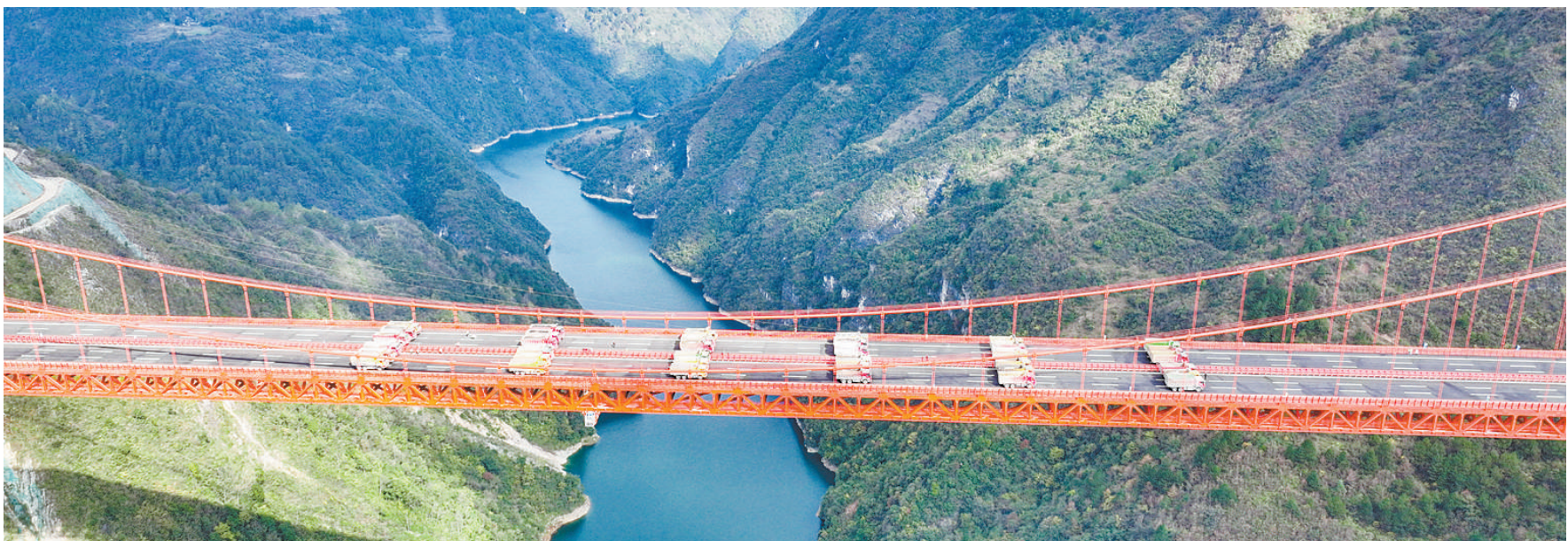
11月30日，贵黄高速公路控制性工程阳宝山特大桥开始进行静态荷载试验，48辆满载共计1680吨货物的大型货车停放在桥上，以检验桥梁结构整体的施工质量与受力性能，为桥梁交（竣）工验收、通车安全提供重要的科学依据。阳宝山特大桥位于贵州省黔南布依族苗族自治州贵定县新巴镇和德新镇境内，大桥全长1112米，主跨650米。图：进行静态荷载试验的阳宝山特大桥（无人机照片）。新华社发（邓刚摄）
