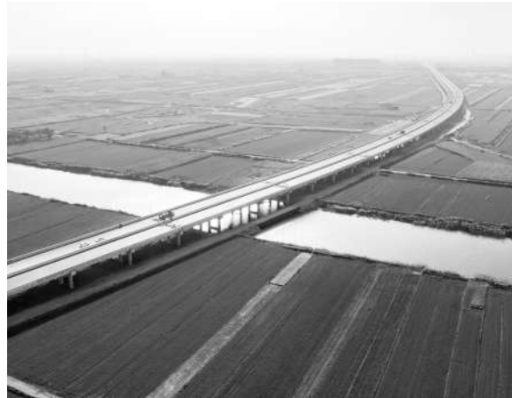
11月22日,由中铁二十二局承建的国道G205津冀界至黄骅绕城起点段改建项目完成,标志着京津冀交通一体化工程开始陆续完成。
