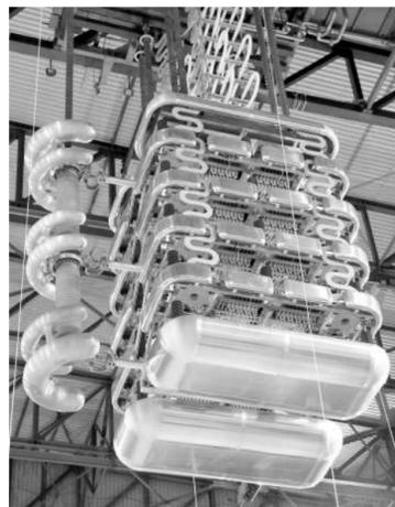
国家电网公司±800KV特高压换流阀及网控设备
