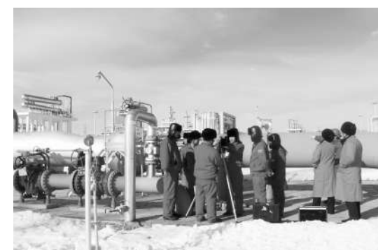
天研院技术人员在现场检测,为进口天然气气质把关。
