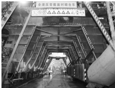
中铁隧道局集团研发的全液压变截面衬砌台车获得国家实用新型专利
