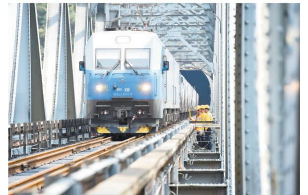
位于重庆市北碚区的嘉陵江铁路钢梁大桥建于1970年。由于当时受施工技术限制,横跨嘉陵江只能采用钢梁桥全木枕结构。这条成渝铁路的“咽喉”要道,每天承担着近百趟旅客列车及重载货物列车通行任务,至今已“服役”48年。由于该桥的特殊性,越是极端天气对大桥的影响越大,一群“护桥卫士”对这座大桥进行不间断的检查养护作业,以保障铁路桥梁的安全畅通。图为8月14日,“护桥卫士”在避车台避让列车。
