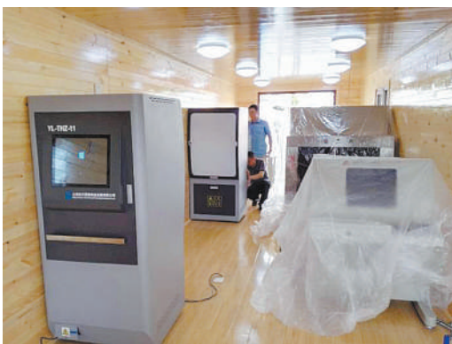
杭州洲际酒店员工通道
