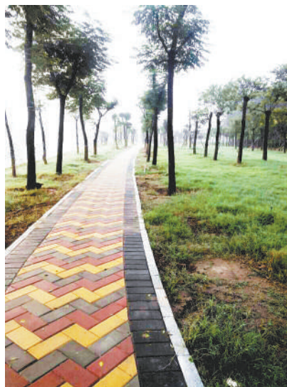
路面铺设的是许昌金科资源公司用建筑垃圾生产的再生透水砖,透水、储水、生态环保。 本报记者 乔地摄
