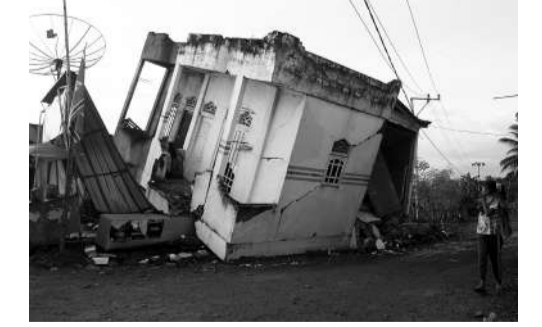
12月7日清晨,印度尼西亚齐特区发生6.4级地震,大量房屋建筑被毁,上万人无家可归。上图一名灾民在临时居所里休息。下图一座受损房屋。新华社
