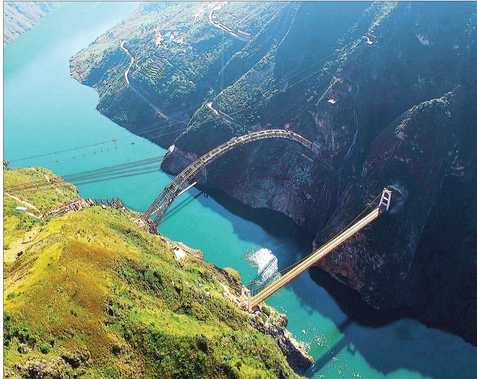
11月15日,由中国中铁大桥局采用“二次竖转”工法施工的大桥——新建大理至瑞丽铁路澜沧江特大桥钢拱拱实现高精度合龙。澜沧江特大桥是新建大理至瑞丽铁路大保段的“咽喉”工程,大桥横跨澜沧江两岸,位于横断山脉西段,全长528.1米,主跨342米,为上承式劲性骨架钢混混凝土提篮拱桥。 新华社发
