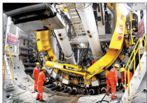
11月11日,工人随着前行的掘进机进行混凝土构件安装。
