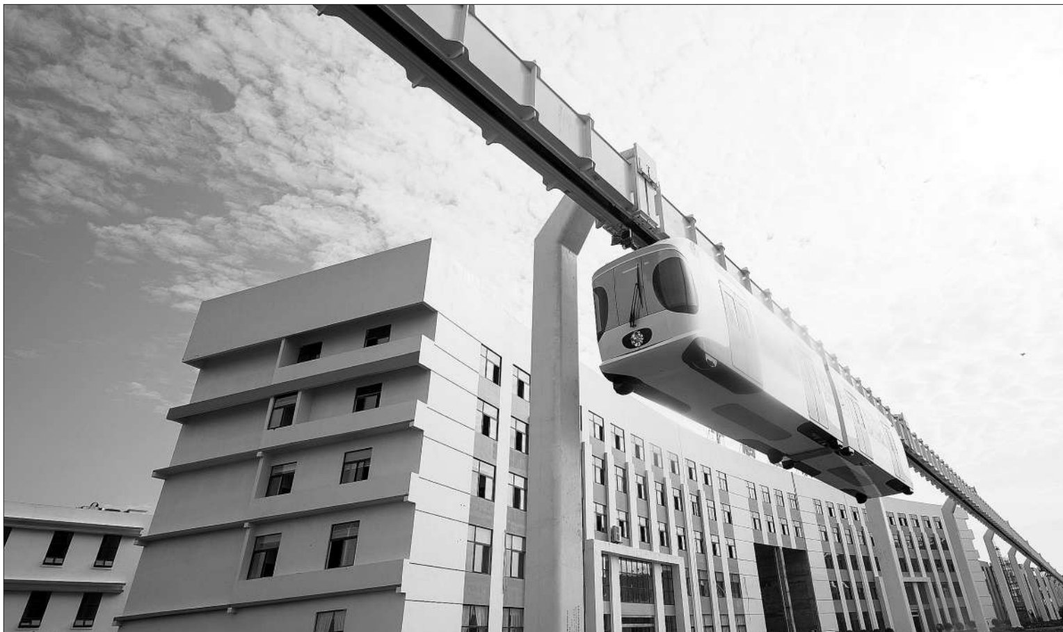
9月30日,我国首列新能源悬挂式空中列车成功挂线。根据规划,整条试验线全长为1.25公里,涵盖缓坡、弯道、车站、充电桩等多种路况和设施,满足整个系统试验所需。目前试验线已建成约300米左右的轨道。工程师介绍,悬挂式空中列车设计时速为60公里,单节车厢定员120人。该系统集成了轨道交通领域若干相关成熟技术,并且创造性地将锂电池包代替高压电用于列车的牵引动力,在世界上属于首创。由于具备绿色环保、占地面积小、建造成本低、建造周期短、适应性强等特点,该系统将来可为城市公共交通和景区交通接驳提供新的选项。
