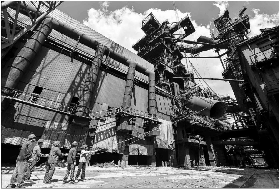
8月31日，施工人员在工地牵引被拆除的2号高炉下降管。当日上午，包头钢铁集团炼铁厂2号高炉拆除工作正式启动，这是全国钢铁行业推进去产能以来拆除的最大一座高炉，可压减炼铁产能133万吨。新华社记者 连振摄
