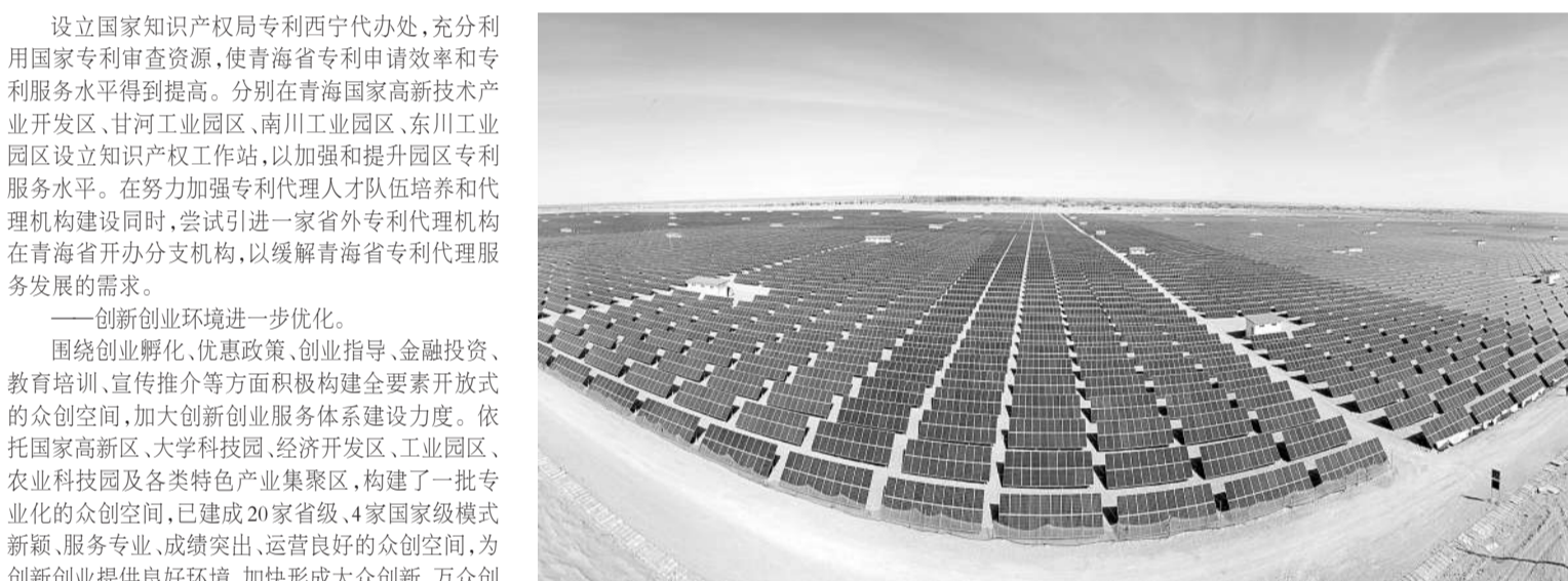
黄河水电公司格尔木200兆瓦并网光伏电站
