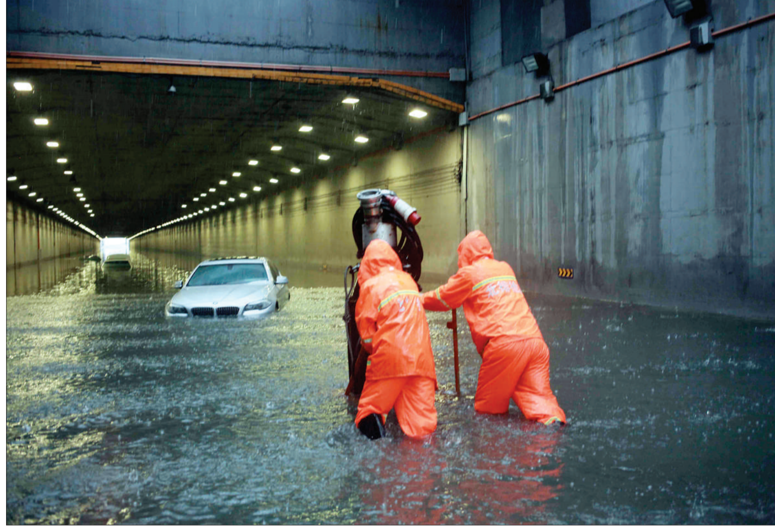
7月20日，北京排水集团的工作人员在北京西站北广场前主路隧道进行紧急排水作业。当日11时30分，北京市气象台发布暴雨橙色预警，目前城区及南部地区6小时累计降水量达70毫米左右，局地超过100毫米，至20日晚强降雨持续。（新华社记者 邢广利摄）
