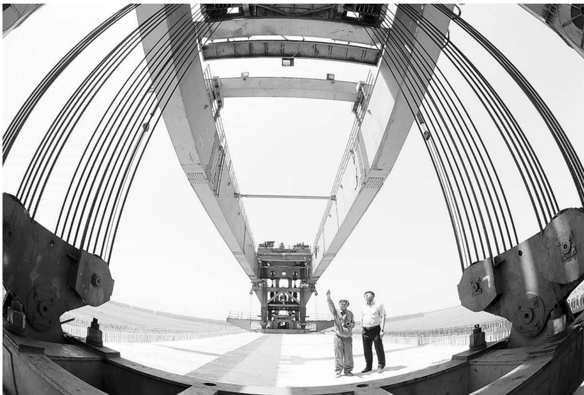
推距离72.35米,这三个数字无不个个重千钧。蒲河特大桥钢箱拱桥是中国高铁首座采用整体顶推法施工的钢箱拱桥,桥梁跨度、顶推重量都创造了高铁整体顶推桥梁建设的纪录。
