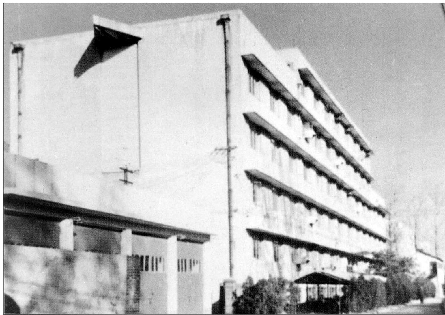
1953年底建成的中关村原子能楼。由于质子静电加速器体量大大,在楼西侧留下两层贯通的入口,并在楼顶特制三角顶板,以便吊装筒等设备入楼。
