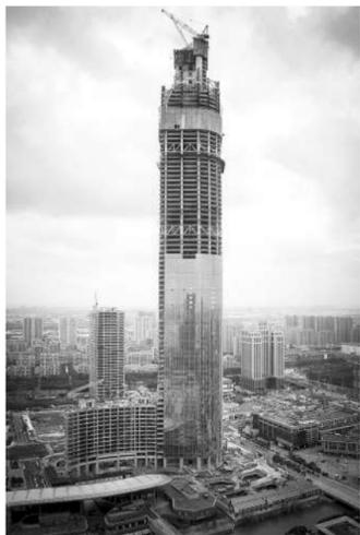
近日,中建钢构承建的苏州国际金融中心项目以398.8米的高度实现主体结构封顶,登顶江苏省主体结构第一高楼。苏州国际金融中心占地面积2.2万平方米,总建筑面积36.7万平方米,建筑高度450米。主塔楼92层,地下室四层,总用钢量约6.1万吨。
