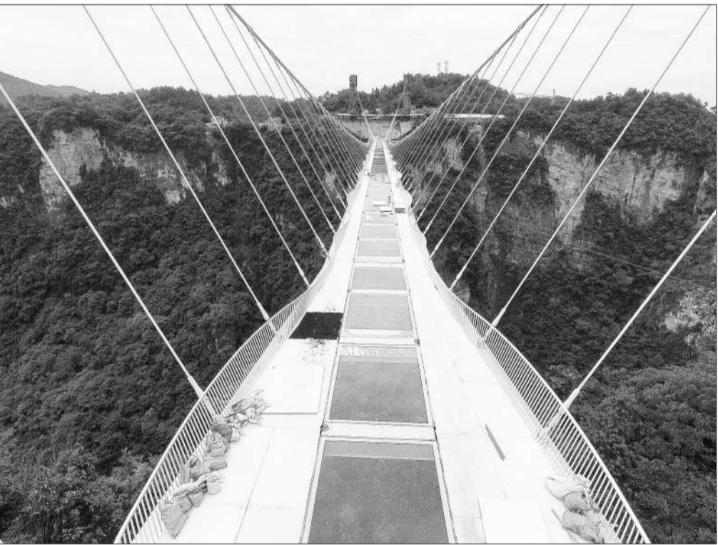
近日,湖南张家界大峡谷人行玻璃桥完成桥面玻璃安装。据悉,张家界大峡谷玻璃桥总长430米,宽6米,桥面距离谷底相对高度约300米。桥面全部采用透明玻璃铺设,最大游客容量为800人。图为桥面玻璃安装到位的张家界大峡谷玻璃桥。新华社记者 龙弘涛摄
