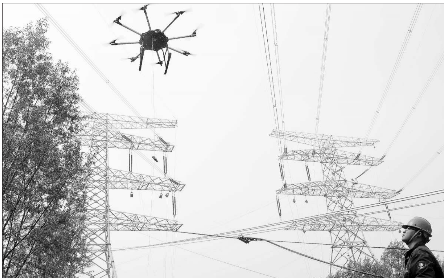
4月28日,锡盟—北京—山东1000千伏特高压送电北京输电工程进入导线展放阶段。首条下送通道计划将于6月建成投运,届时内蒙古东部地区的清洁电力将源源不断送入京津冀地区,缓解京津冀地区电力供应紧张局面,有助于改善环境空气质量。
