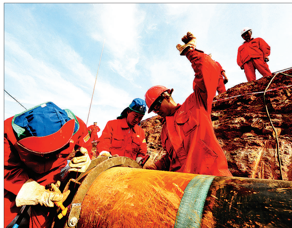
精心施工,连通管网,变产能为产量。
