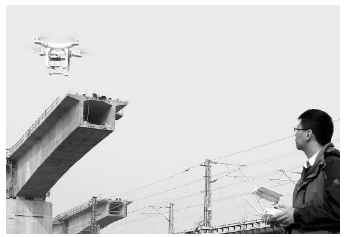
日前,在中铁四局瑞(昌)九(江)铁路RJZ0-2标项目(五公司)工地现场,项目专业航拍人员正利用无人机“空诊”方式对现场施工安全、质量和进度等进行巡查监控。随后,该监控被制作成3分钟的短视频片报送到该局工程处,用于周一全局施工生产交班会情况汇报。这是该局利用无人机为项目安全施工装上“天眼”的一个缩影。
