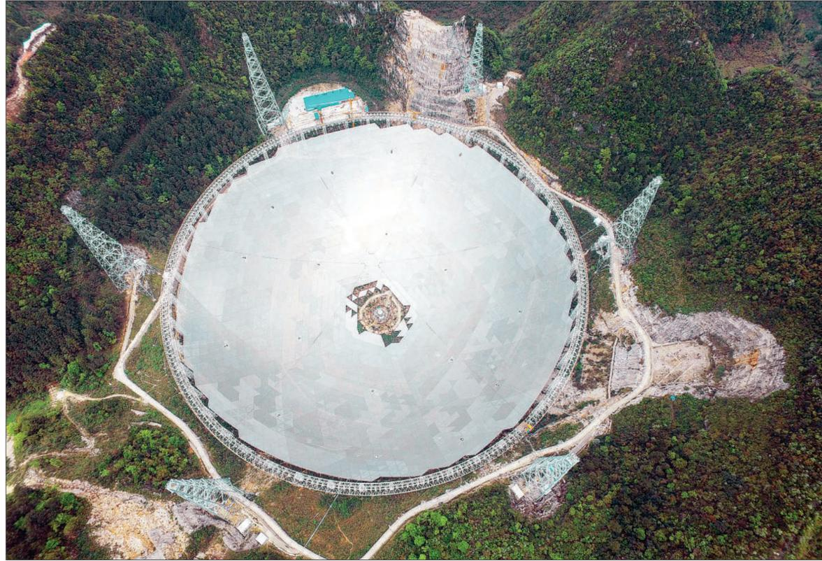
截至4月10日,正在贵州省平塘县建设的世界最大单口径射电望远镜——500米口径球面射电望远镜(FAST),已完成4185块反射面面板安装,完成比例达94.04%,工程进入收尾阶段,反射面安装工程预计将于今年5月中旬完成。图为正在建设中的500米口径球面射电望远镜(FAST)工程。新华社记者 欧东衢摄
