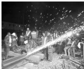
图为施工人员在切割需要接驳的线路钢轨,火花飞溅。张伟明摄影报道
