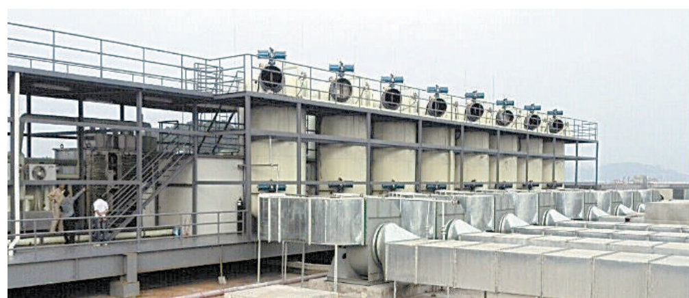
深圳彩印环保工程:产品型号WUS-10000-60,风速流量(m 3 /h)60万,适用浓度(mgVOCs/m 3 )3000,回收率(%)95,处理后VOCs浓度(mg/m 3 )20,使用寿命(年)10,装机功率(kW)200,运行费用(元/年)100万
