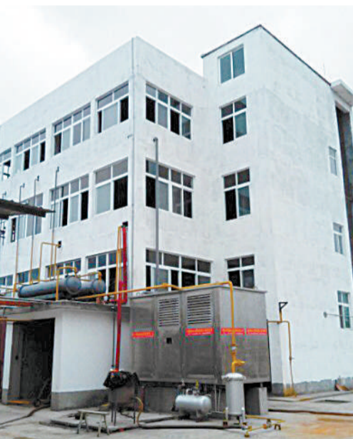
陕西阳县振邦科技汽油回收工程:产品型号WUS-10000-001,风速流量(m 3 /h)100,适用浓度(mgVOCs/m 3 )3000,回收率(%)95,处理后VOCs浓度(mg/m 3 )20,使用寿命(年)10,装机功率(kW)10,运行费用(元/年)5万
