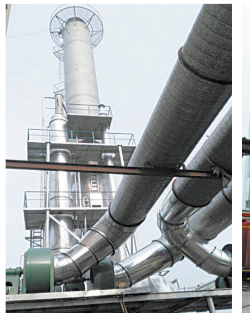
苏州腾达纺织后整理厂工程:产品型号WUS-10000-10A,风速流量(m 3 /h)10万,适用浓度(mgVOCs/m 3 )3000,回收率(%)95,处理后VOCs浓度(mg/m 3 )20,使用寿命(年)10,装机功率(kW)100,运行费用(元/年)30万
