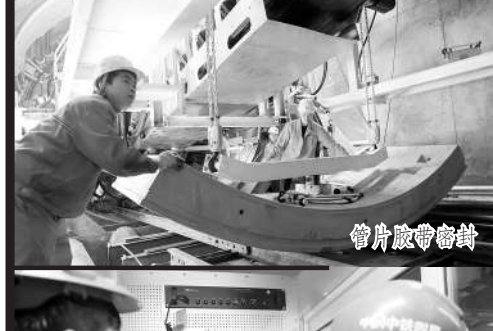
石家庄地铁盾构施工
