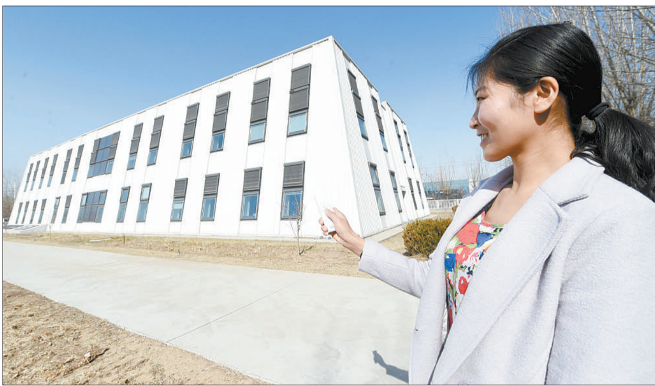
依据主动式建筑理念设计,位于廊坊开发区的威卢克斯中国总部新办公楼利用地源热泵空调机组,没有安装一台空调,一个暖气片就实现了室内四季如春。根据监测数据记录,该栋大楼年耗能为每平方米33千瓦时,是同类型建筑的五分之一,与同类建筑相比,每年可以减少碳排放250吨。图为该公司员工用遥控器对室外遮阳帘进行智能操控。
