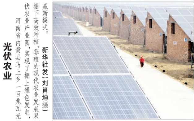
新华社发(刘肖坤摄) 棚下高效种植,养殖的现代农业发展双轮驱动,实现了棚上绿色发电,河南省内乡县马店乡一百兆瓦光伏农业
