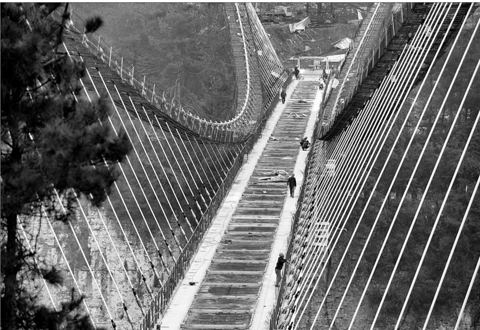
1月27日,备受关注的张家界大峡谷人行玻璃桥正式开始桥面玻璃铺设工程,预计两周内完成全部玻璃铺设。张家界大峡谷玻璃桥桥面由三层玻璃叠加而成,共99块,整个玻璃面的承载量至少达60吨。据悉,张家界大峡谷玻璃桥总长430米、宽6米,桥面距离谷底相对高度约300米。桥面全部采用透明玻璃铺设,最大游客容量为800人。
