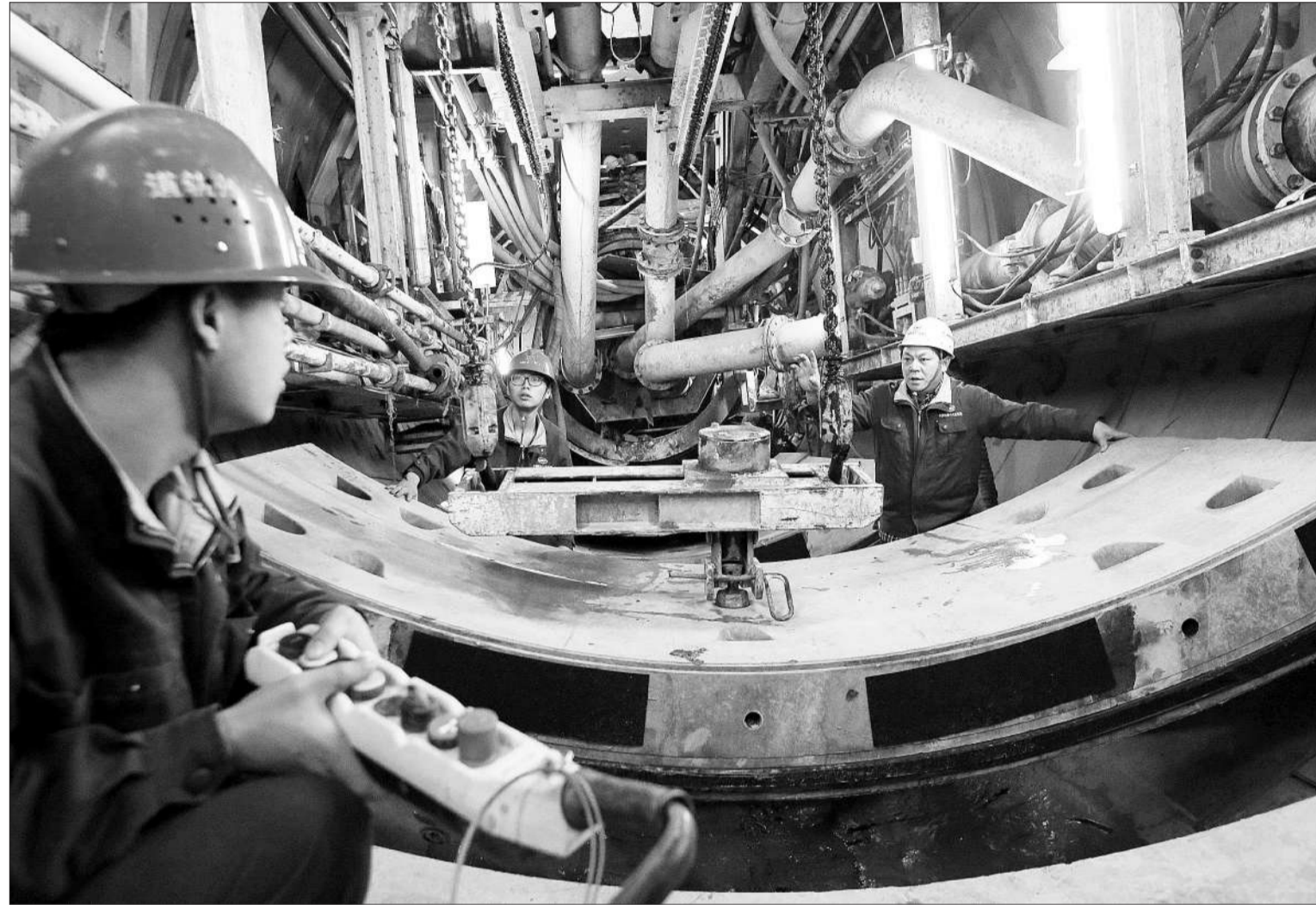
日前,由中铁十六局集团承建的兰州轨道交通1号线5标“金城5号”盾构机成功抵达黄河南岸河堤,标志着国内首条地下穿黄河盾构隧道成功穿越黄河天险。它的成功穿越黄河,为我国今后在复杂的地质结构下施工积累了宝贵的经验。 王浩然 成海忠摄
