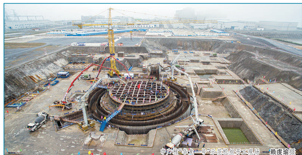
中广核“华龙一号”示范机组开工现场 魏彦瑜摄
