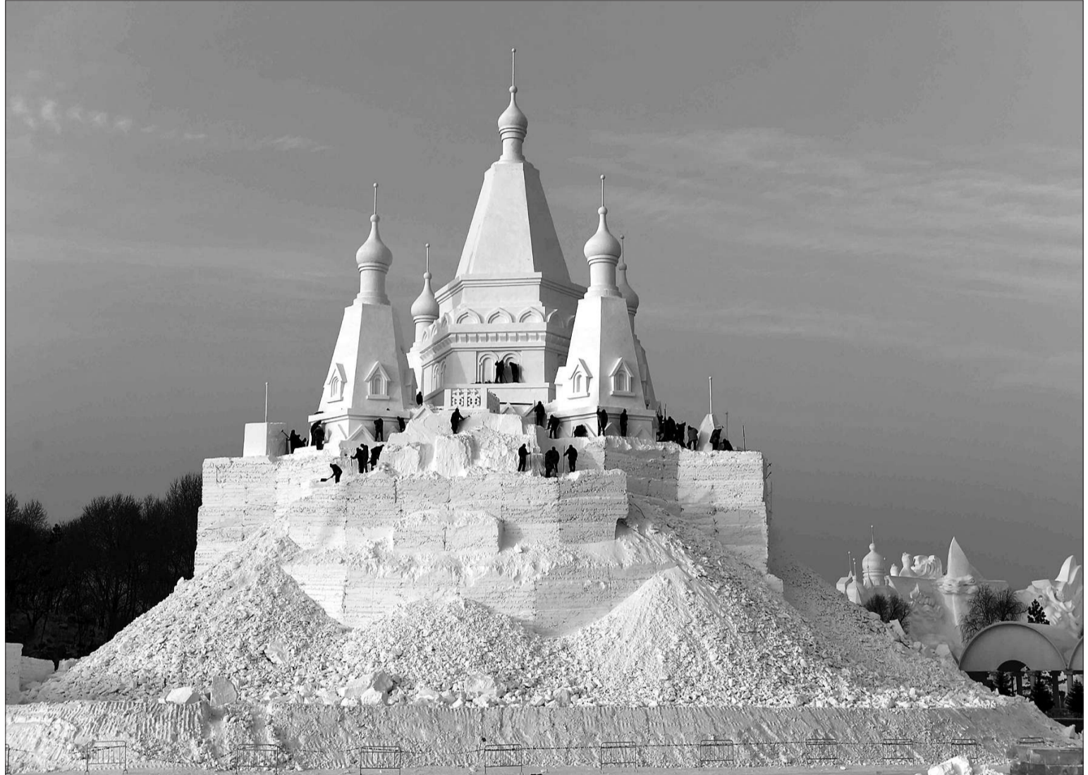
12月24日,在太阳岛雪博会园区内,雪雕技师在对雪塑建筑“冰雪之冠”进行雕塑。当日,在第28届哈尔滨太阳岛国际雪雕艺术博览会园区内,雪塑建筑“冰雪之冠”正在加紧雕塑中,预计将于2016年初完工。该建筑高达51米,占地面积2800平方米,用雪量约为3万立方米,将被打造成世界最高雪塑建筑。新华社记者 王建威摄
