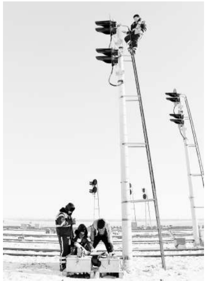
施工人员在安装调试高柱信号机。
