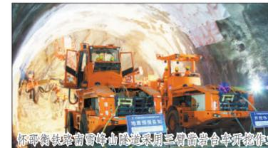
怀邵衡铁路南雪峰山隧道采用三臂凿岩台车开挖作业
