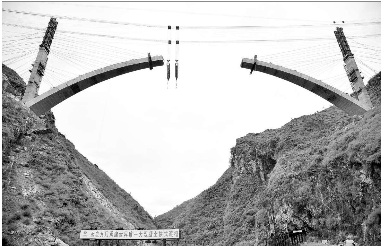
站在贵州黔中水利水源地建设工地的山头上,眼前157米高的大坝将奔腾不息的乌江上游三岔河水拦腰截断形成“高峡平湖”,群山环抱的库区碧波荡漾。黔中水利于2009年正式动工兴建,是贵州首个大型跨地区、跨流域长距离调水工程,承载了上千万人近60年的期盼。这项曾被称为“异想天开”的工程,突破了多项喀斯特地区搞水利建设的世界级难题,为全球破解喀斯特地区工程性缺水难题带来诸多启示。图为已建成的黔中水利枢纽总干渠龙场渡槽当时在建场景。新华社记者 骆飞摄
