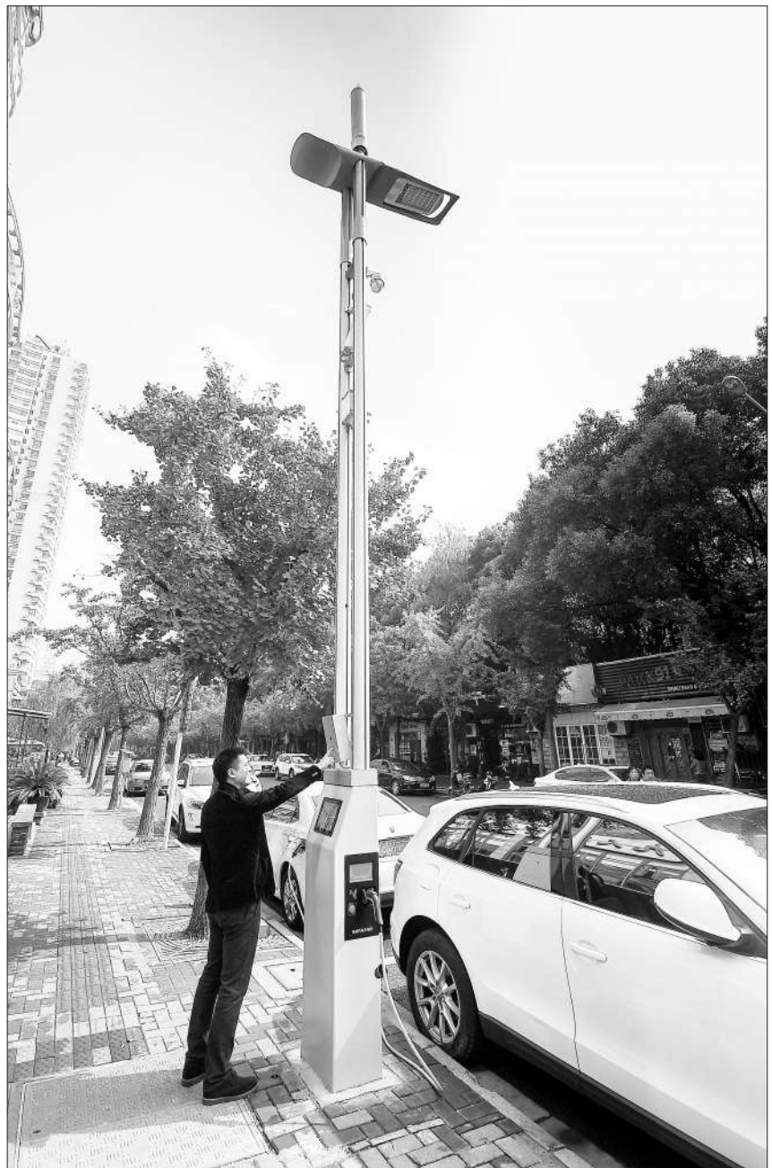
近日,一种新型的“智能路灯杆”在上海街头亮相。这种路灯杆除具备传统的照明功能外,还可以用做电动汽车充电桩、监测PM2.5的环境设备,实现WiFi覆盖的城市微基站、传达信息的信息查询系统等。图为上海大沽路街头的“智能路灯杆”。新华社记者 丁汀摄
