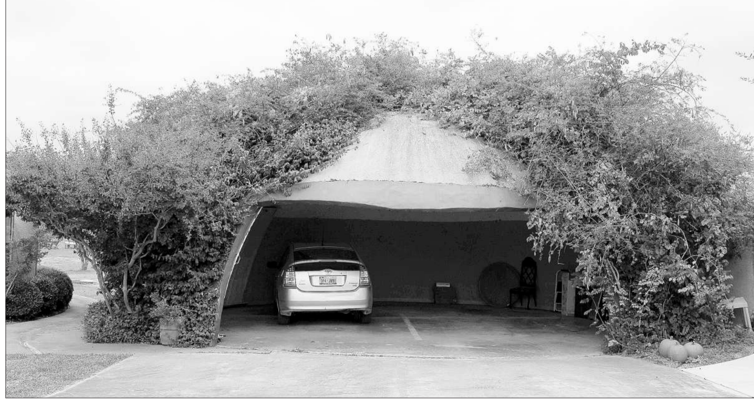
这是10月22日在美国得克萨斯州拍摄的用作车库的圆顶屋。在美国得克萨斯州达拉斯南部约一小时车程的35号公路边,有一群造型奇特的圆顶屋。圆顶屋用空气泡沫、钢筋混凝土和聚氨酯泡沫隔热材料建造,具有高效环保、经久耐用、易于维护等特点。最重要的是,它在供暖和制冷方面比同样大小的传统建筑可节能约50%。
