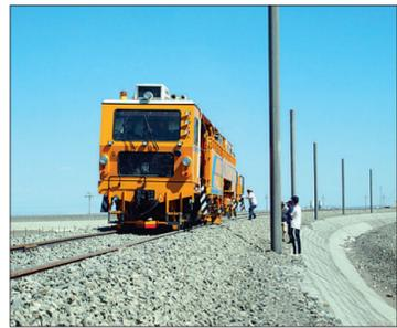
郑红梅摄 捣固作业。 河至津浦铁路矿区段进行大养机公司津浦三项目正在为新铺八柳十月十五日,中铁四局集团八分
