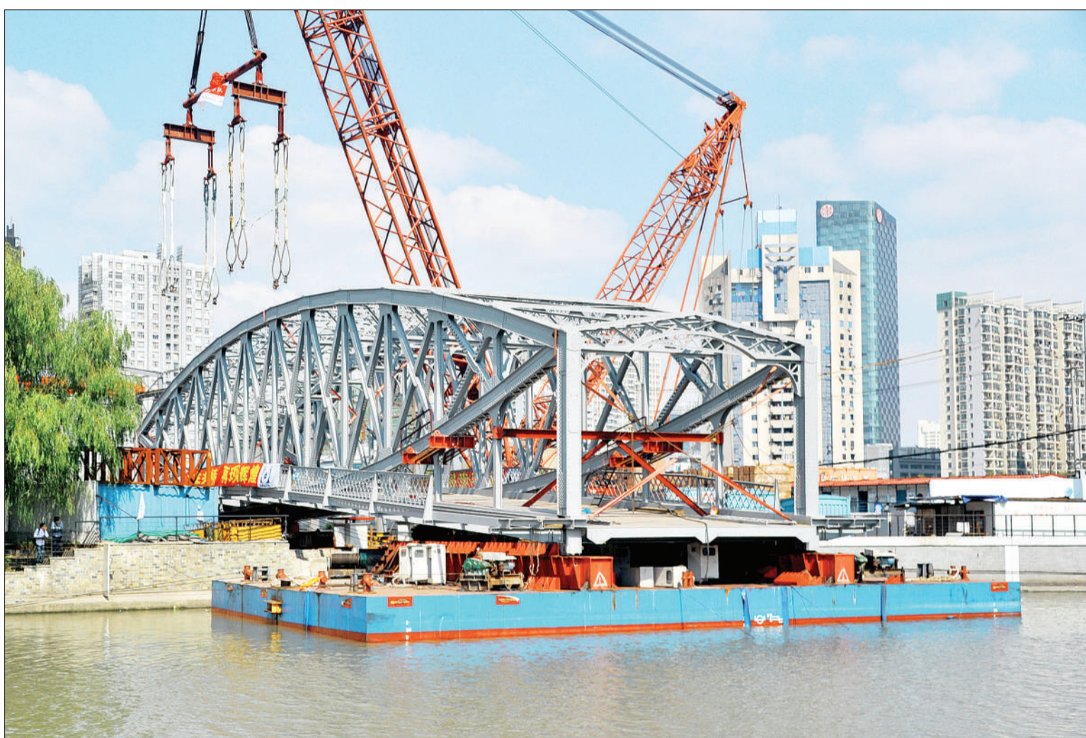
10月18日,航拍107岁的上海浙江路桥“回家”。
