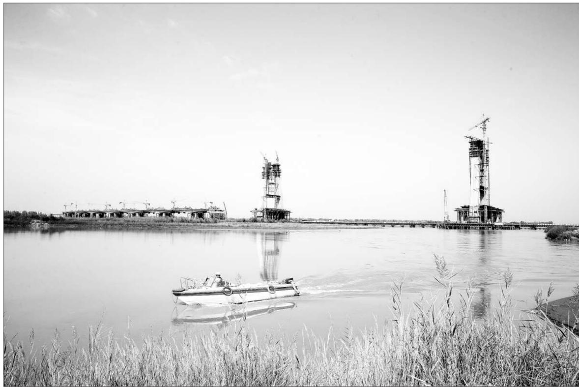
10月7日,由中铁十六局集团建设者在宁夏永宁黄河公路大桥70多米高的主塔上精心施工,为11月底大桥主塔顺利封顶紧张工作。据悉,永宁黄河公路大桥位于永宁县境内,全长3.74公里,河面主跨260米,是宁夏首座采用双塔双索面斜拉景观桥。
