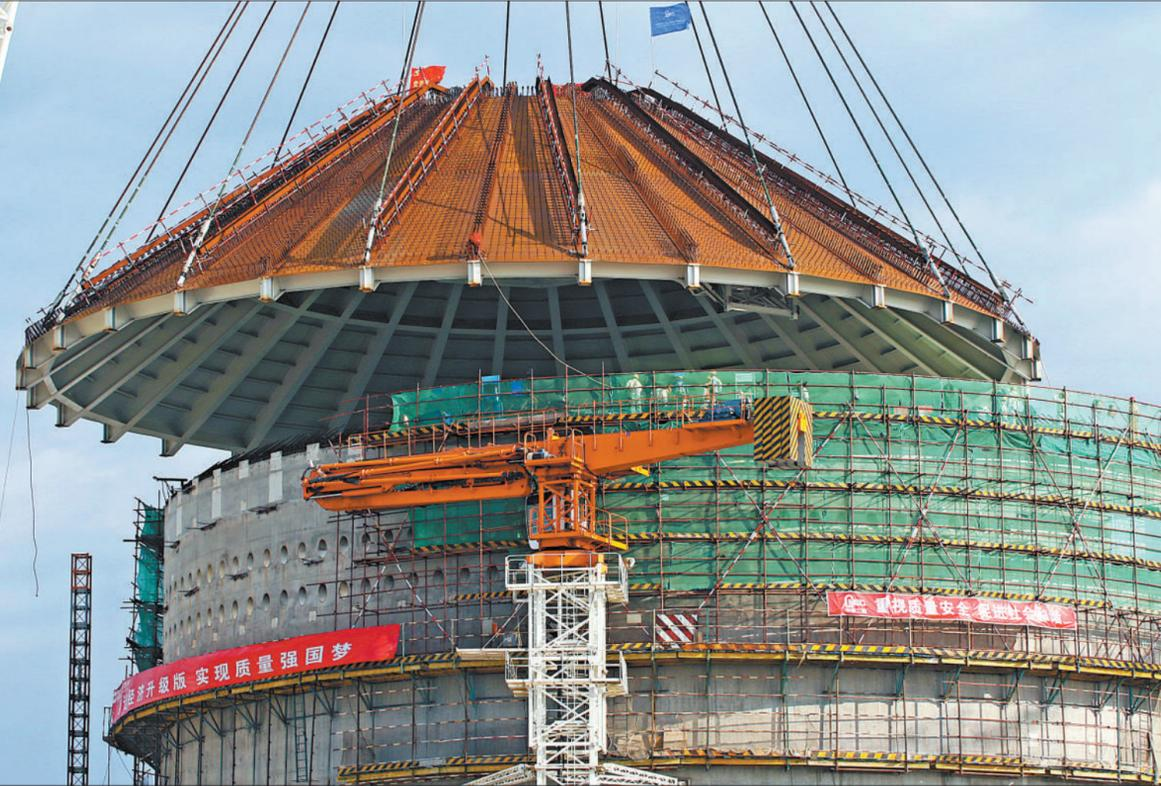
9月12日,重达899吨的山东省海阳核电站2号核岛穹顶成功吊装就位,标志着2号核岛主厂房结构基本完工。目前,海阳核电站1号、2号核岛及相关机组已进入移交调试高峰阶段。投入运营后,年发电量将达175亿千瓦时,对优化山东电源结构,节能减排起到积极作用。图为海阳核电站2号核岛穹顶正在吊装。 新华社发(唐克摄)
