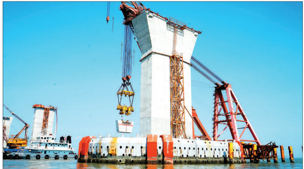
9月6日,港珠澳大桥的墩台均告完工。这标志着这座跨海大桥建设进入了工程冲刺阶段。新华社记者 魏蒙摄
