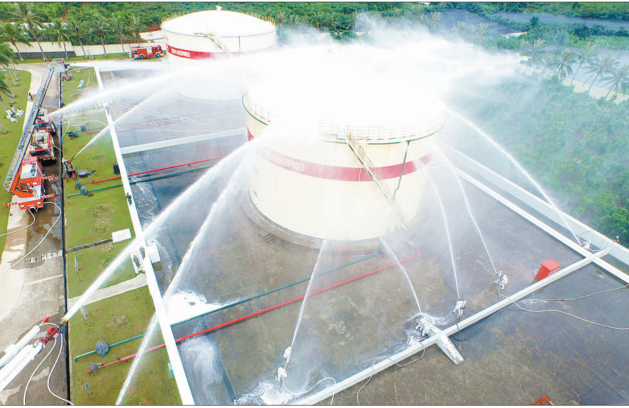
8月31日，海口市公安消防支队在海南美亚实业有限公司举行防范化学危险品泄漏大规模机动演练。演练模拟“机场油库泄漏起火，形成立体式燃烧”灾情，接警后调集3个消防中队、机场专职消防队，17辆各型消防车赶赴现场进行救援。图为消防员在演练中用泡沫对发生泄漏的油罐进行冷却。
