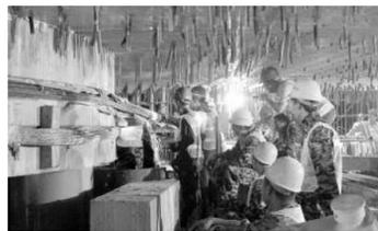
8月13日凌晨3时59分,重达13500吨的“巨无霸”39号墩身及梁体在33米高空经过79分钟的81.5度平稳旋转,成功转体到位。
