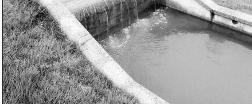
在中国最大的垃圾焚烧发电厂——安徽合肥市肥东县撮镇镇循环经济示范园的中节能生活垃圾电站,垃圾渗滤液经高技术处理后清澈见底,可以养鱼;垃圾焚烧后的炉渣经无害化处理,可做成环保建材。整个流程实现“零排放”。本报记者 翟剑摄
