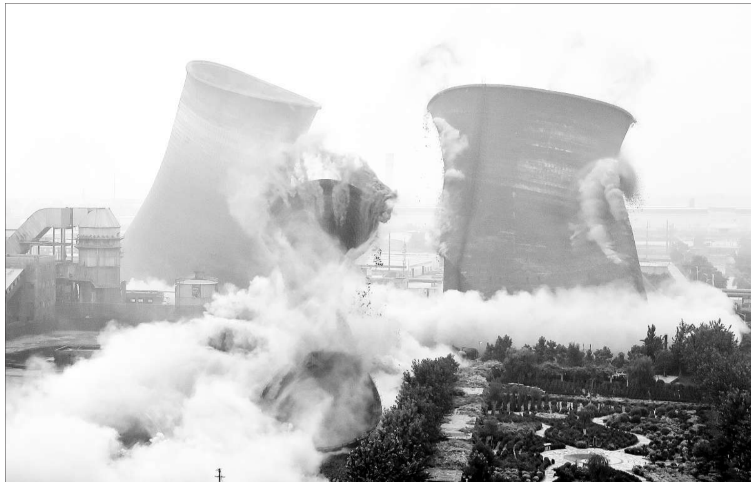
8月11日,山东省集中爆破聊城在平县信发集团7台总装机容量68万千瓦的燃煤机组,标志山东省清理整顿环保违规建设项目进入实质性阶段。
