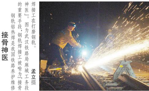
焊接工在打磨钢轨。
