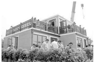
7月17日,一个由3D打印的模块新材料建造的别墅现身西安。在别墅的建造现场,有独立的客厅、卧室、厨房、卫生间等模块,工人们陆续将这些建筑模块用起重机吊起来,拼接安装。不到3个小时,一栋2层别墅就落成了。负责设计生产的企业卓达集团研发工程师安永亮介绍,90%的建房工序已经在工厂完成,即所有的建筑模块在工厂流水线生产,现场只是对这些模块进行拼接、组装、搭建。“修建传统的别墅大约要花费半年的时间,而3D打印模块搭建别墅从生产到搭建只需要十几天的时间。”安永亮说,目前这套精装别墅有6个模块,每平米重100千克,成本价格在每平米2500元—3500元。尽管房屋建造时间短,但每个模块都能够独立承重,能够抗9级地震。同时,钢结构笼式结构还能够充分填充保温材料,达到很好的保温效果。
