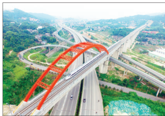
右图 6月28日,福州开往合肥南的G2626次高铁列车经过福州境内的跨西岭互通特大桥。
